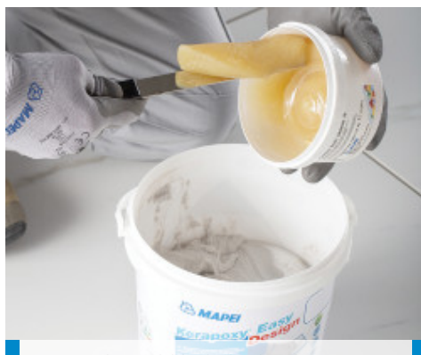
Utwardzacz (składnik B) należy przełożyć do pojemnika zawierającego składnik A
