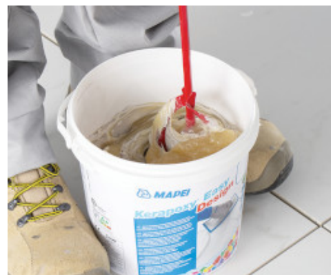
Oba składniki należy dokładnie wymieszać ze sobą
