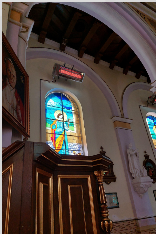
Promienniki w zabudowie specjalnej przeznaczone do ogrzewania kościoła
