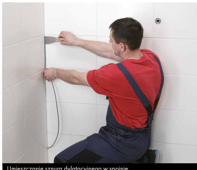
Umieszczanie sznura dylatacyjnego w spoinie
