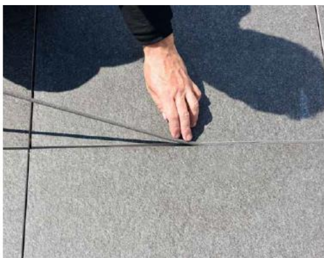
9 Zaprojektowane szczeliny dylatacyjne wypełnić szczelnie przylegającym sznurem dylatacyjnym.
