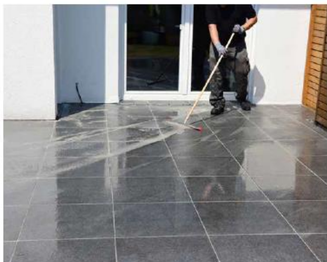
15 Nadmiar zaprawy fugowej usunąć...
