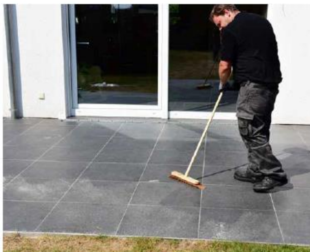
16 ...a resztki zaprawy zmieść.
