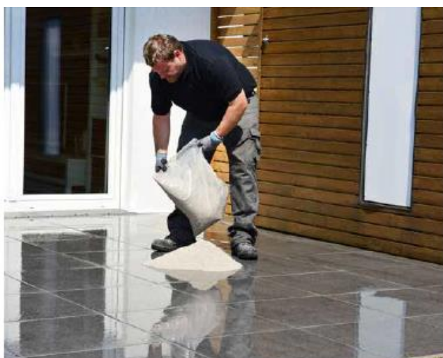
11 Fugę Sopro Solitär® F20 wyłożyć na okładzinę.
