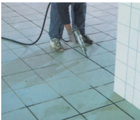
Spoinowanie posadzki za pomocą pistoletu pneumatycznego
