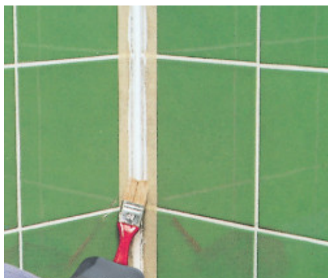
Wyglądanie spoiny za pomocą wody z mydłem i pędzla
