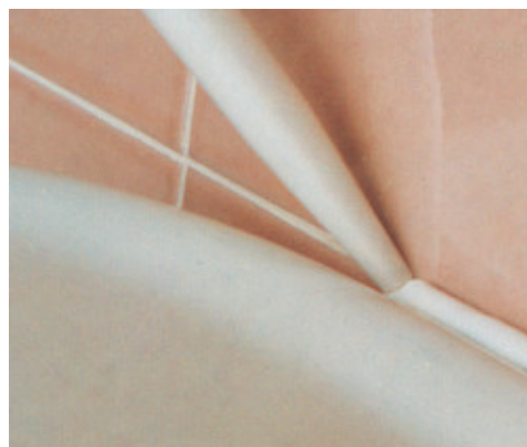
Spoinowanie ceramiki sanitarnej przy użyciu Mapesil AC
