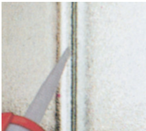
Spoinowanie elementów szklanych
