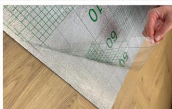
4. Zdejmij folię zabezpieczającą. Pod nią znajdziesz warstwę samoprzylepną.
