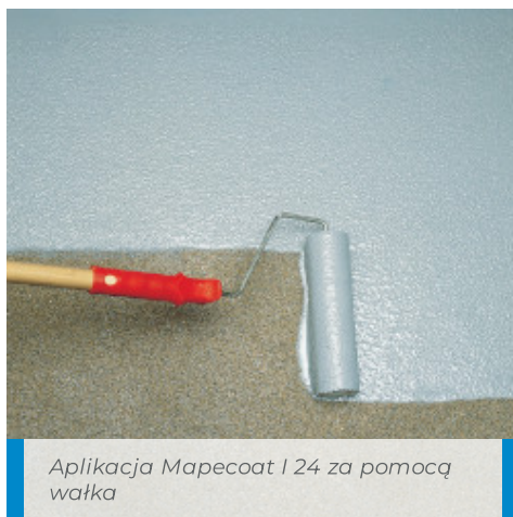
Aplikacja Mapecoat I 24 na podłożu betonowym
