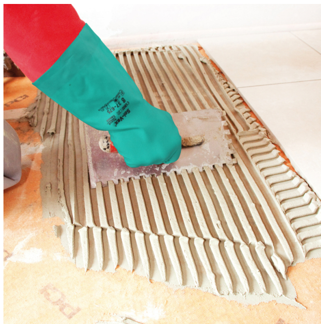
Stosując elastyczną zaprawę klejącą przykleić okładzinę płytkową.
