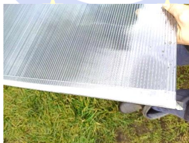
Rysunek 9 – łączenie U-profilu.
