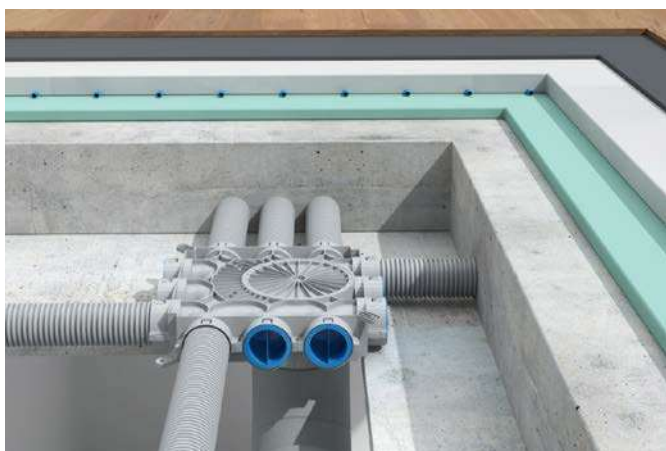
Możliwość prowadzenia przewodów w konstrukcji budynku
