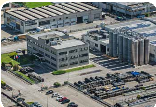
Sede Operativa - Castel Guelfo di Bologna (BO)
