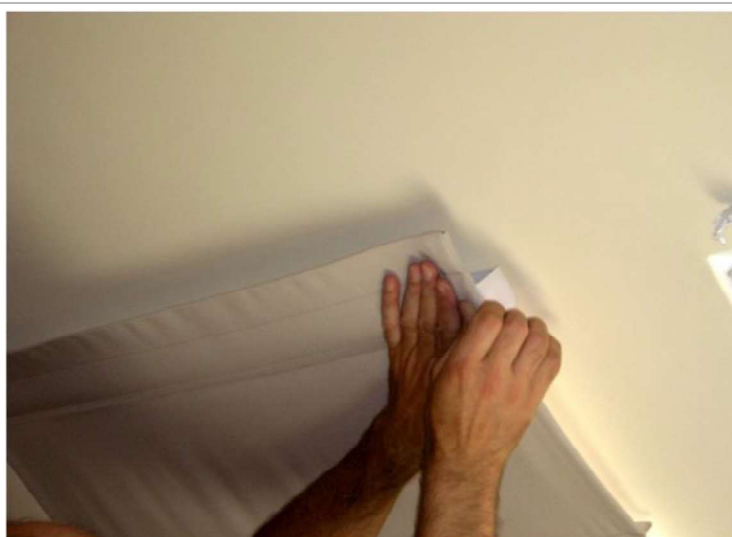
Podciągamy tkaninę rolety w kierunku mechanizmu i przytwierdzamy do rzepa mechanizmu
