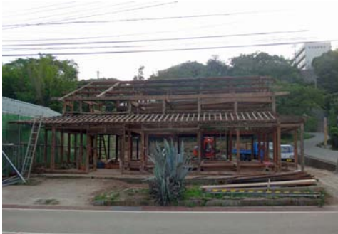
外壁を取り払い、これらの資材を再利用し建築される
