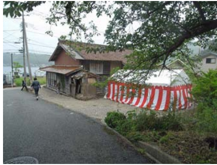
西側から見た解体前の古民家(菱浦・高校下)
