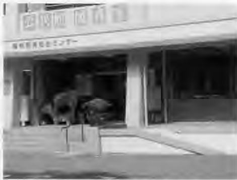
H17.12.に工事完了した隠岐開発センター正面玄関右側階段手すり
