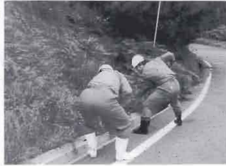
側溝土砂撤去作業
