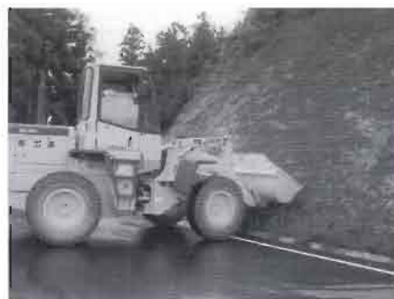
土砂崩れ発生想定により撤去作業
