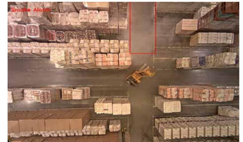
FireCatcher Camera est parfaitement adapté aux environnements à hauts plafonds, comme ici dans un entrepôt. Le phénomène de stratification qui empêche la remontée des flammes ne perturbera pas le bon fonctionnement de la solution installée.
