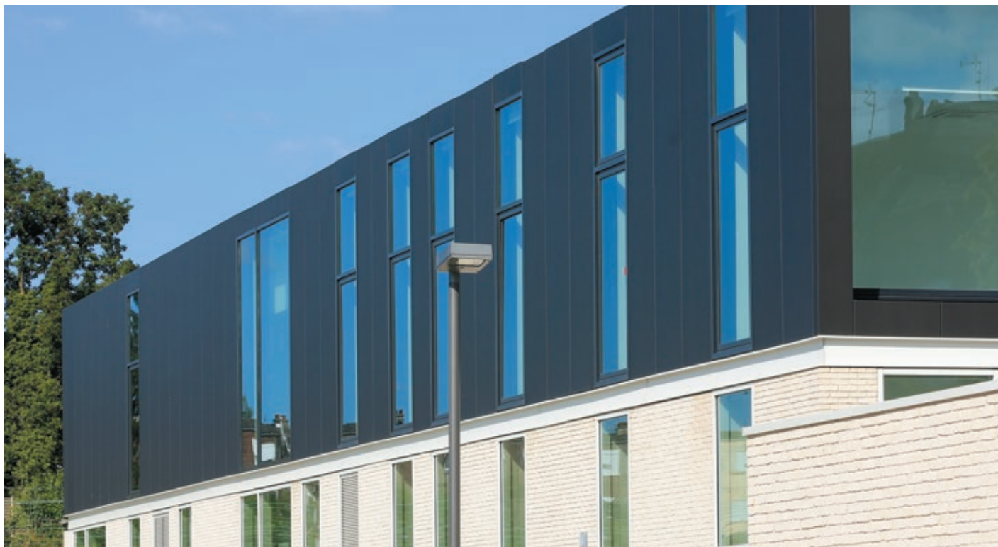
Centre de formation, Cambrai (France) - Architecte : Codelfy et Associés Architectes Urbanistes (CAAU) - Entreprise : Farasse Toiture B-e - Aspect : ANTHRA-ZINC®
