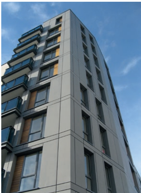
Collindale Avenue, Flats, London (UK) - Architecte : Watkins Grey International - Entreprise : LCS Roofing & Cladding - Aspect : QUARTZ-ZINC®
