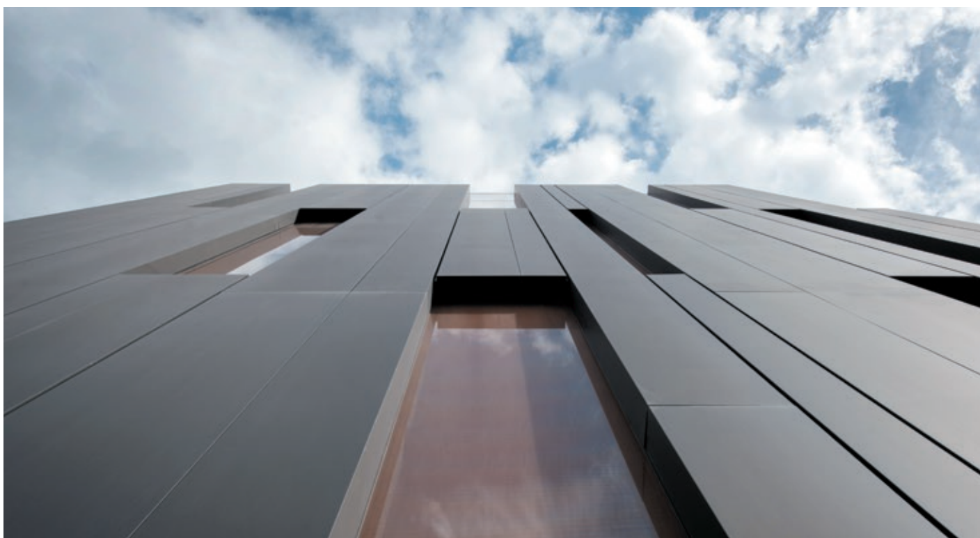
Asset Bank, San Marino (Italie) - Architecte : STUDIO ARCHINOW : Gazzoni, Dellarosa, Foschi - Entreprise : ISA SPA - Photographe : Giovanni De Sandre - Aspect : ANTHRA-ZINC®
