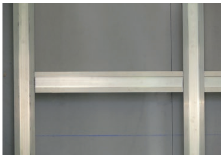
Point de dilatation sur profil horizontal
