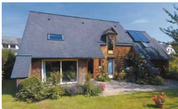
Isoler votre toit ! 25 à 30 % de la chaleur s'échappe par la toiture.
