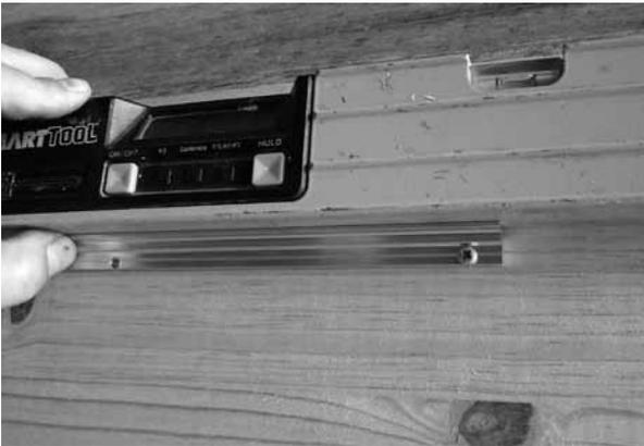
Mettre le rail à niveau, tracer et percer un trou tous les 50 cm environ.
