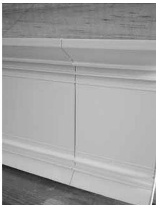
Le rail permet un ajustement parfait des segments de plinthes
