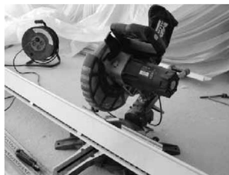
Ouvrir la plinthe, déposer la batterie de chauffe, remettre la façade et couper l'ensemble. Ne pas couper les clips (faire glisser si besoin).
