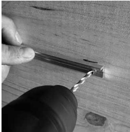
Positionnez le rail et percer un trou à une extrémité. Une rainure sur le rail permet de centrer le foret.
