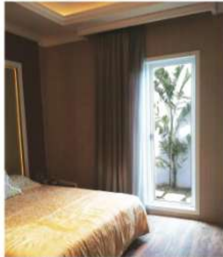
Jendela uPVC (Kamar Tidur).
