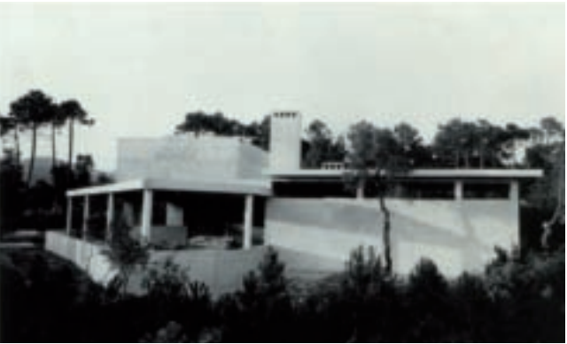
Club-House du golf de Beauvallon, façade latérale sur la terrasse et les vestiaires hommes. Photographie de Thérèse Bonney.
