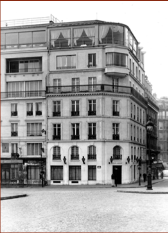
La façade renovée et rehaussée © Tour d'Argent Paris
