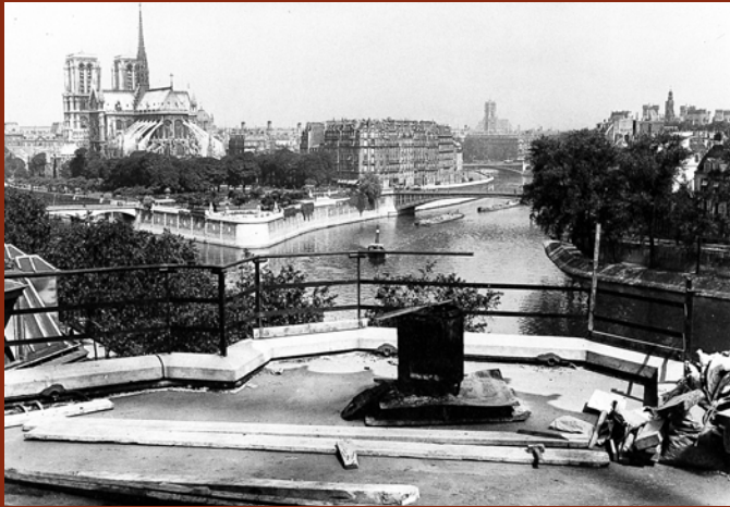
Les travaux du sixième étage © Tour d'Argent Paris
