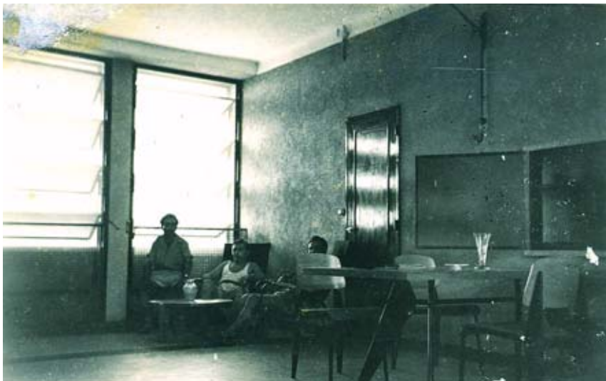
Intérieur de l'immeuble Air France à Brazzaville
