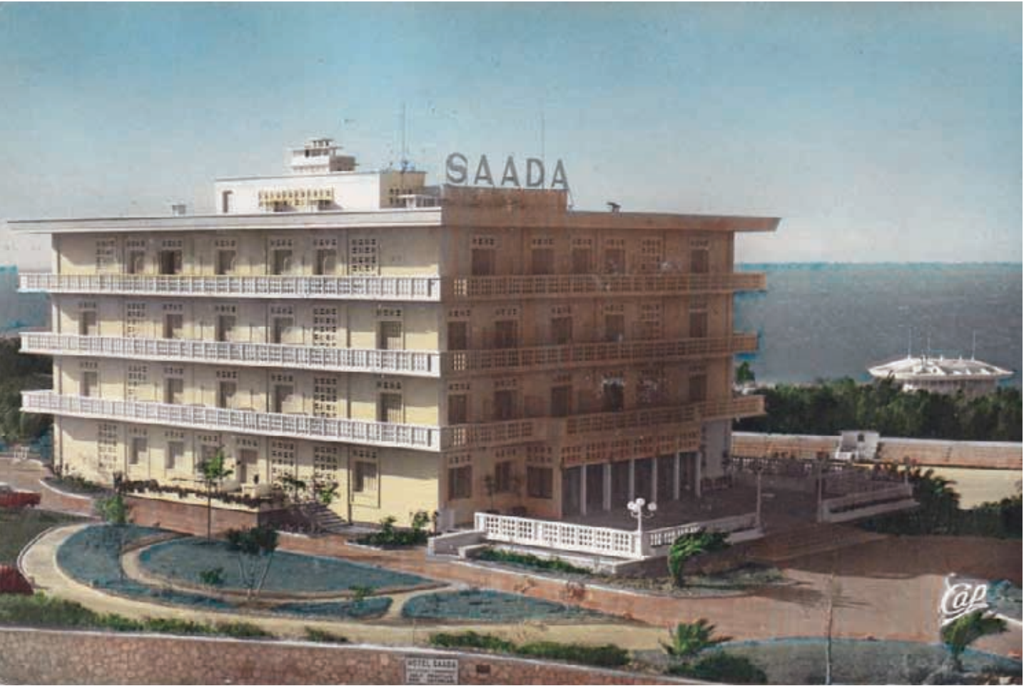
L'hôtel Saada ( Le Bonheur en arabe ) – Construit en 1951-2 Selon les plans des architectes Jacques Poirier, Georges Bordes, Abran et M. G Bassières, Inauguré en 1953, boulevard Lebrun (Boulevard Mohamed V)
