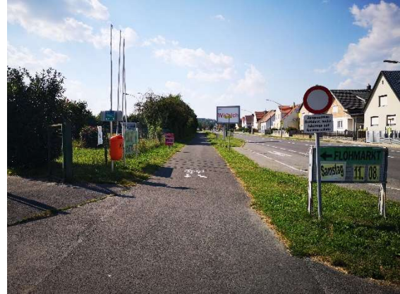
Gute Radwegverbindung Mittelpullendorf - Unterpullendorf
