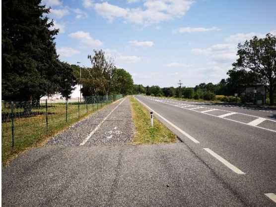
Neutral Richtung Stoob: Radweg entlang der B50
