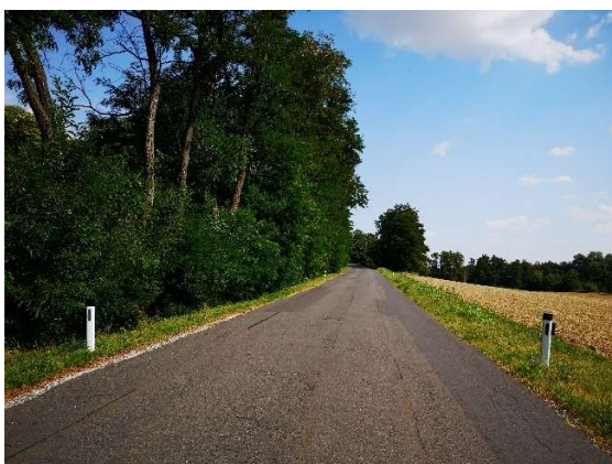
Richtung Großmutschen: Radroute im Mischverkehr (70 km/h-Beschränkung)
