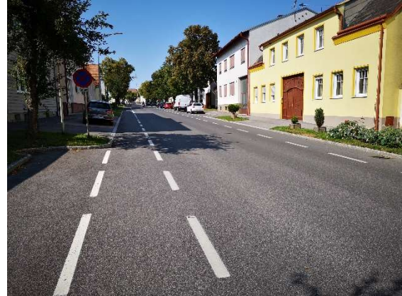
Markt St. Martin: Bestehender Mehrzweckstreifen an der B50 in der Ortsdurchfahrt
