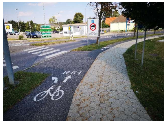
Problematische Breiten (Gegenverkehr) im Bereich des Kreisverkehrs B50/B61
