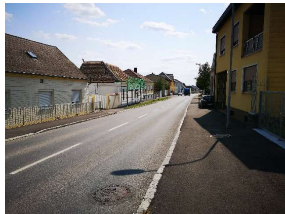
Weppersdorf: Ortsdurchfahrt ohne Radinfrastruktur
