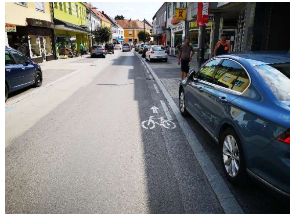
Hauptstraße nördlicher Teil – Markierungen drängen Radfahrerinnen und Radfahrer optisch an die parkenden Autos
