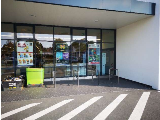
Vorbildliche Abstellmöglichkeit bei Fa. Hofer (nahe dem Eingang, überdacht, stabil abstell- und mit Rahmen verschließbar)
