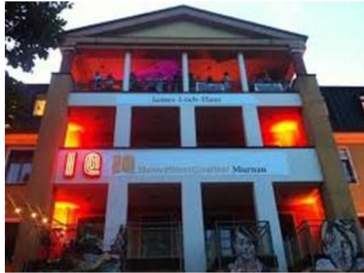
Murnau (D, 12.000 Ew.) Revitalisierung eines leerstehenden Krankenhauses als "Co-Working"-Quartier
