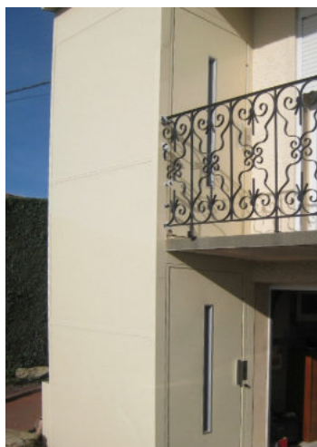
Gaine alu sur pylone autoporteur
