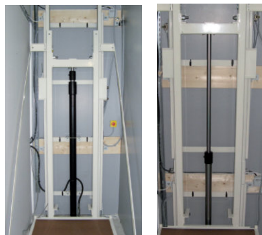
Vérin télescopique synchronisé
