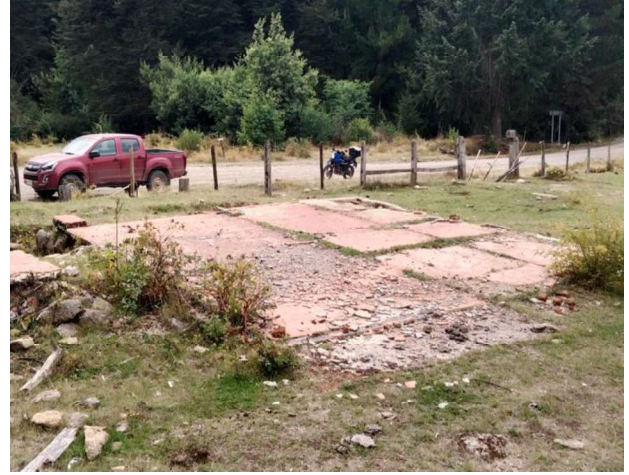
Foto 20. Restos de construcción dentro del AAVC, ej. 2.
