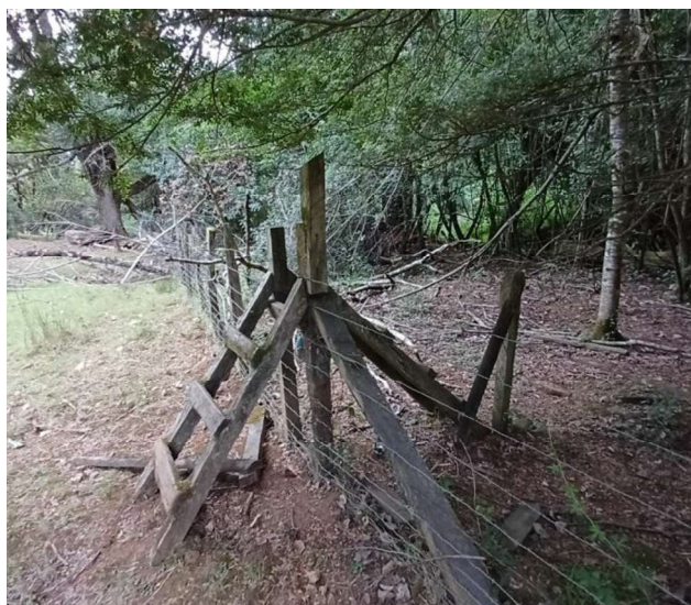
Foto 29. Infraestructura al interior del AAVC.
