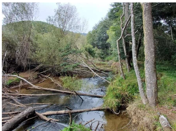
Foto 17. Individuos caídos al cauce del río, ej. 1.
