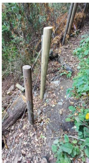
Foto 20. Faenas de mantenimiento de barandas del sendero.
