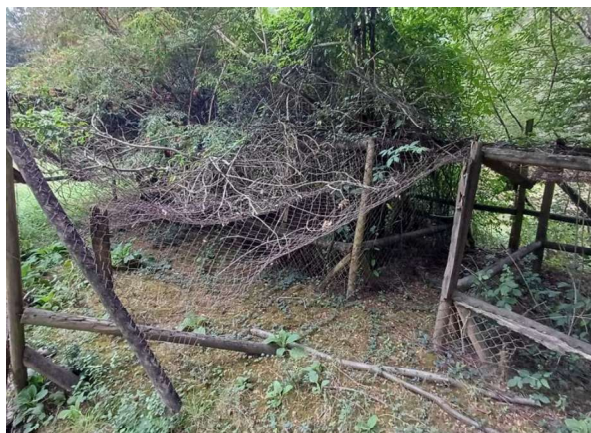
Foto 30. Instalaciones en desuso en AAVC, ej. 1.
