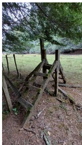
Foto 10. Reparación de cercos y pasarelas, ej. 2.
