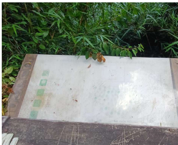
Foto 22. Letreros autoguiados necesitan mantenimiento.
