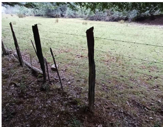
Foto 9. Reparación de cercos y pasarelas, ej. 1.
