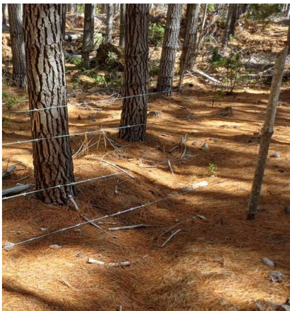
Foto 16. Reparación de cerco.
