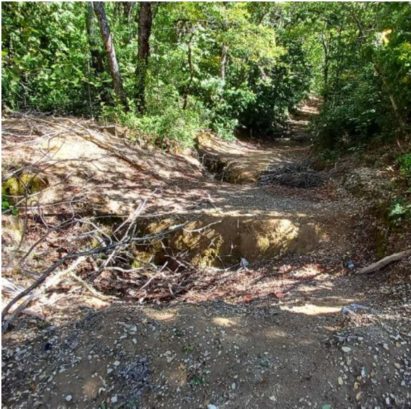
Foto 75 .Zanja que controla el ingreso de personas que cortan madera.
