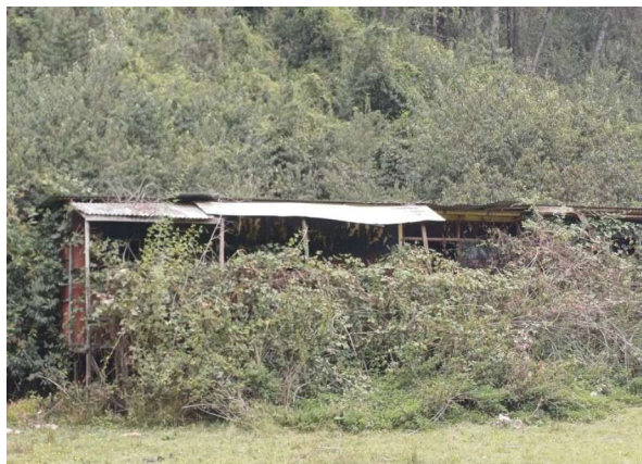
Foto 32. Instalaciones en desuso en AAVC, ej. 3.
