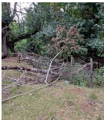
Foto 7. Cerco Perimetral dañado por caída de árbol.
