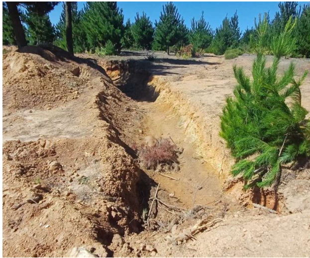
Foto 15. Zanja en el ingreso de AAVC.
