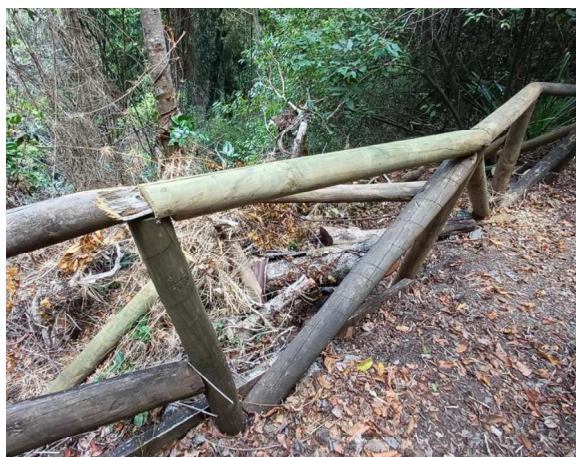
Foto 18. Faenas de mantenimiento de barandas del sendero.
