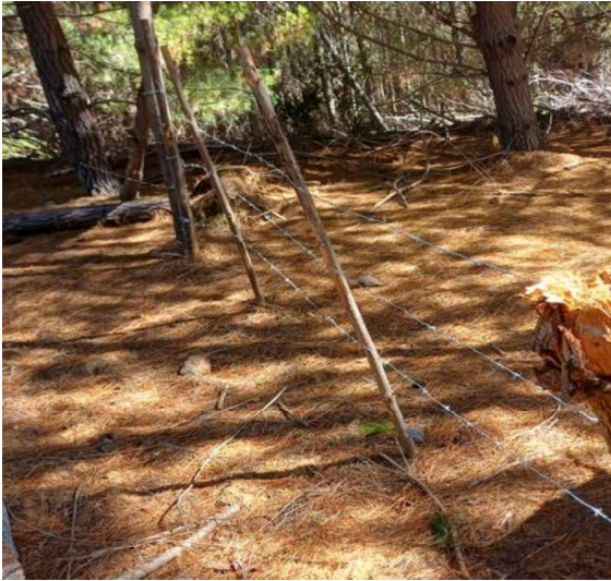
Foto 9. Cerco perimetral reparado.
