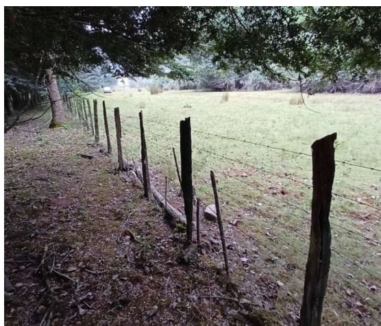
Foto 8. Cerco perimetral deteriorado por el paso del tiempo.
