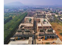
Unit-4, Atchutapuram 1,995 KL A C
