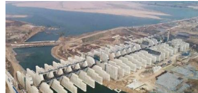
Medigadda Barrage, Telangana
