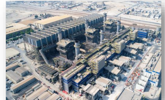
1800 MW Alba CCPP, ETC of GTG, STG, HRSG & BOP, Bahrain
