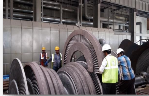
TG Overhauling 600 MW Jharsuguda Vedanta
