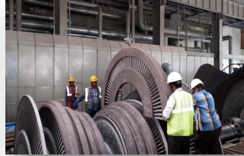
TG Overhauling 600 MW Jharsuguda Vedanta
