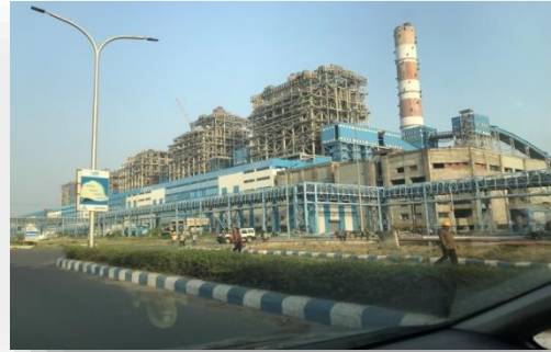
3x660 MW Barh STPP, NTPC
