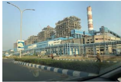
3x660 MW Barh STPP, NTPC
