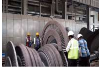
TG OVERHAULING 600MW JHARSUGUDA VEDANTA
