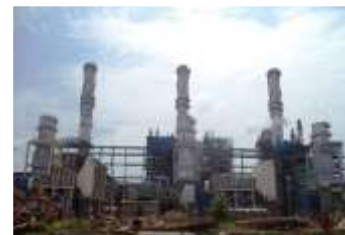
366 MW REFINARY, GTG, STG, HRSG & PIPING, PARADIP, BHEL
