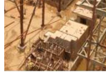
3X660 MW, STPP, STG,BOP ,NORTH KARNAPURA, BHEL
