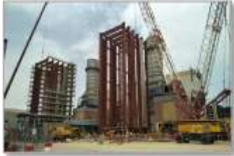
250 MW SABIYA CCPP, KUWAIT INSTALLATION OF HRSG
