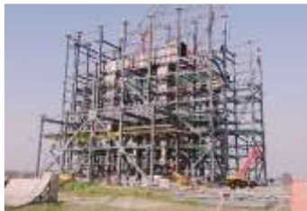
1X660 MW TPP, BTG, HARDUAGANJ, DOOSAN
