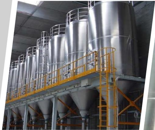
Lagerung Silo und pneumatische Förderung (Druck/Vakuum)
