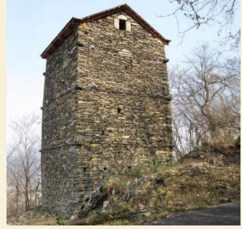
Torre Lossetti - Cardezza
