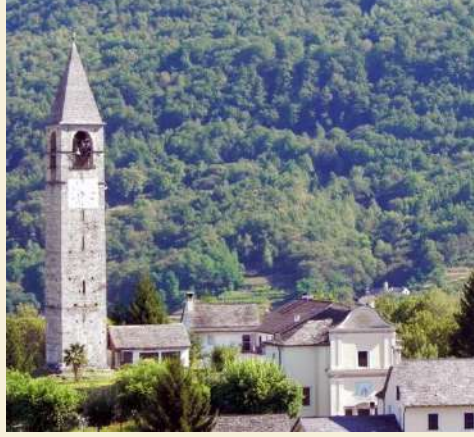
Torre campanaria - Trontano
