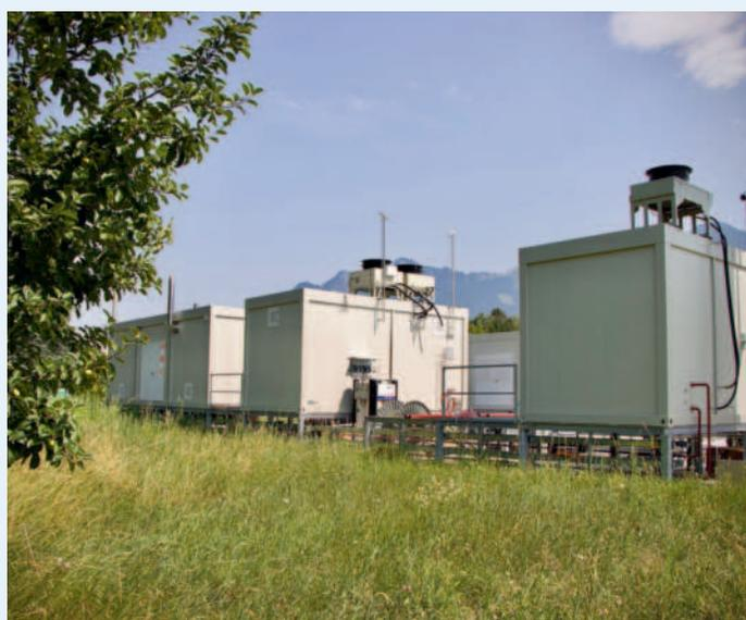
En 2022, l'un de nos réacteurs UPSOM a été installé à Aigle (CH) dans le cadre d'un projet avec Gaznat et l'EPFL. Le système convertit le dioxyde de carbone des sites industriels et l'hydrogène vert produit localement en méthane synthétique.
