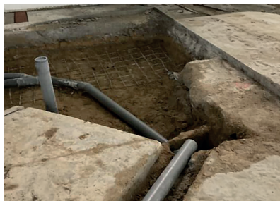
Réfection réseau d'évacuation aux normes
