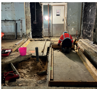
Scellement de process dans l'existant
