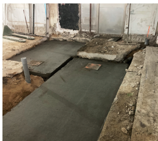
Scellement de process dans l'existant
