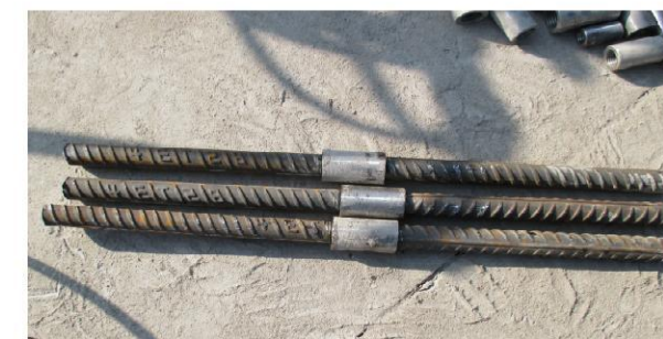
(8)、完成用于工艺评定的试拉件，在监理封存，待送检。
