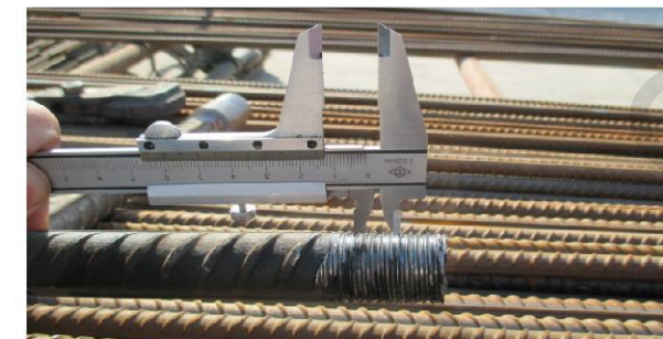
(4)、按接头的外形尺寸加工 \Phi 28 钢筋接头扣数为 (4)10 扣，实际有效扣数为 11 扣按接头的外形尺寸加工 \Phi 28 钢筋接头螺距为 3mm，实际螺距为 3mm。
