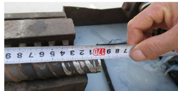
(3)、按接头的外形尺寸加工 \Phi 28 钢筋剥肋长度为 32.5，实际剥肋长度约为 35
