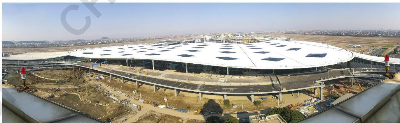
杭州萧山机场扩建
