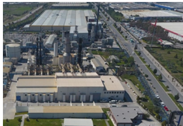
Biyokütle Enerji Santrali Atık Isı Uygulamaları
