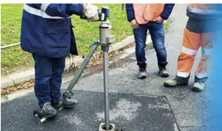
Utilisation de notre kit H<sub>2</sub>O sur une vanne souterraine d'un réseau d'eau
