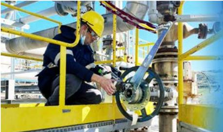
Utilisation d'un actionneur portable sur batterie (MC89) pour atteindre une vanne difficilement accessible de manière sécurisée
