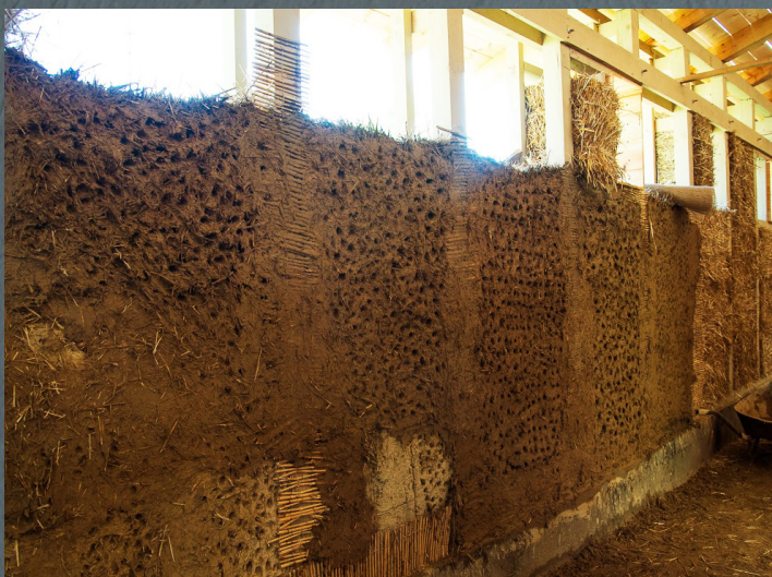
| Vályogvakolat szalmabálára, közte a fa
