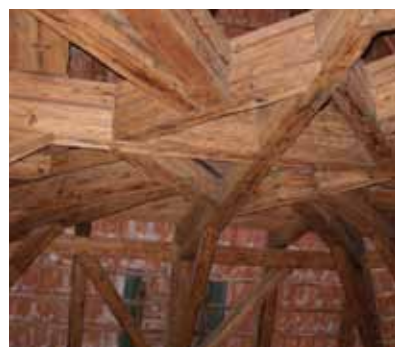
Massive Holzkonstruktion des unteren Dachstuhls im Schwarzen Turm auf der Prager Burg.
