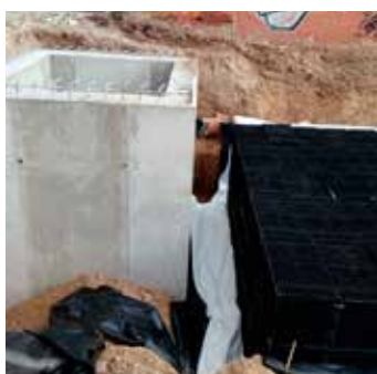
Installation de VORTEX postérieure à un bassin d'infiltration/rétention.
