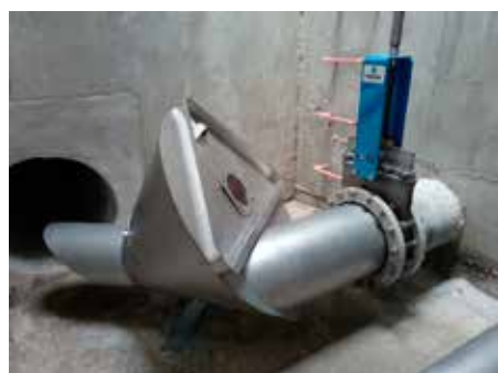
Installation de VORTEX postérieure à un bassin d'infiltration/rétention.
