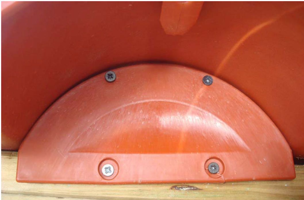
Foto de cierre antipájaros instalado
