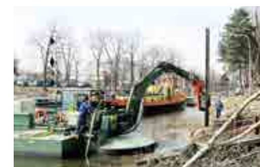
Renforcement des rives grâce au battage de pieux
