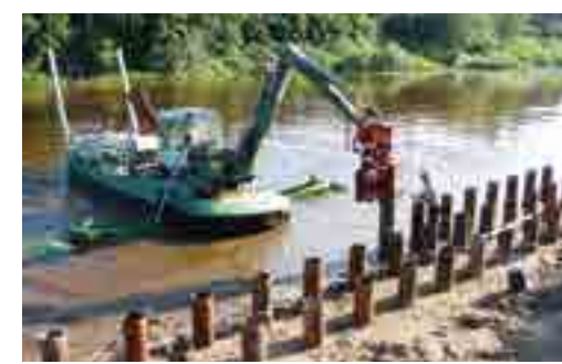
Travail de fondation pour le battage de pieux
