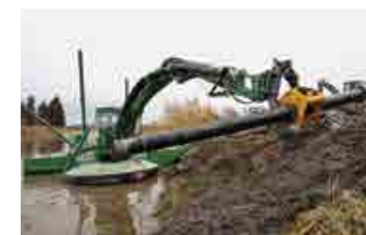
Creusement de tranchées et pose de canalisations et câbles sous l'eau
