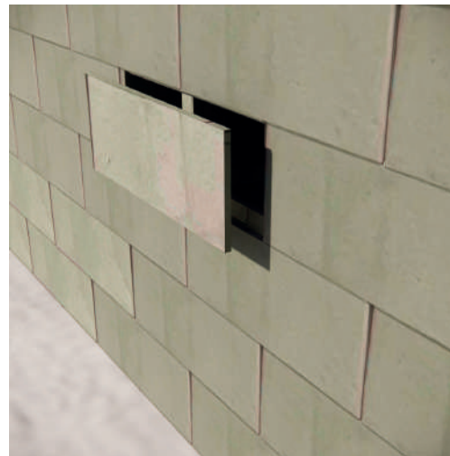
Instalación de la fachaleta.
