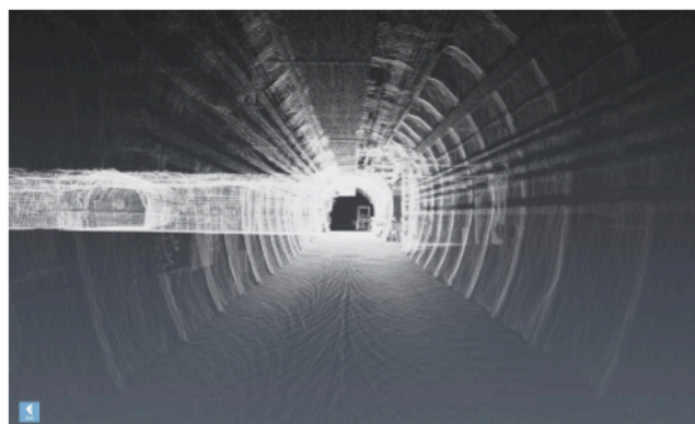
Acquisition de données par LIDAR * - galerie du laboratoire souterrain
