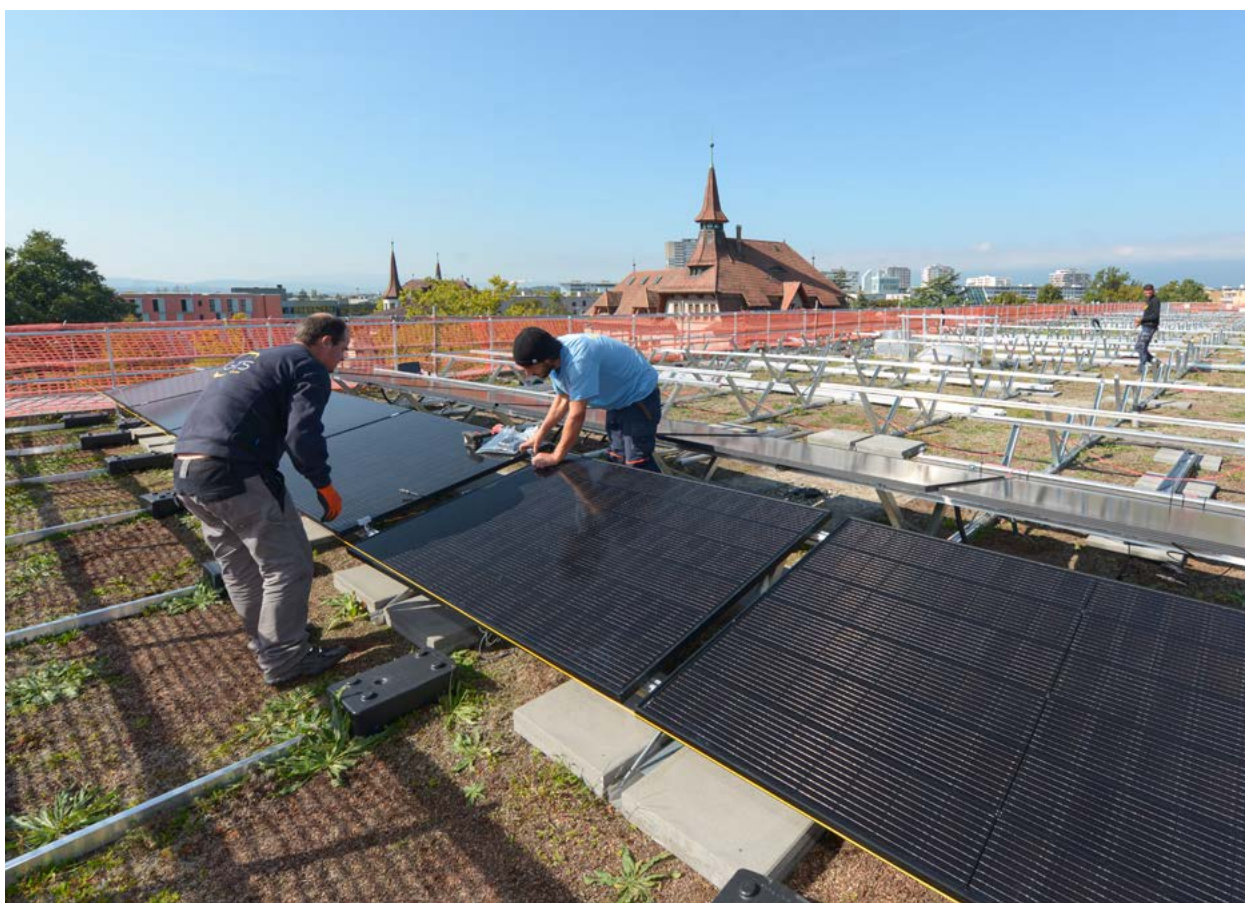
École du Petit-Lancy, Avenue Louis-Bertrand 7, 1213 Petit-Lancy, installation des panneaux solaires photovoltaïques, 2025
